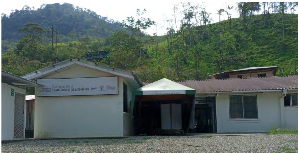
Ilustración 13. Subcentro de Salud de San Carlos de las Minas
