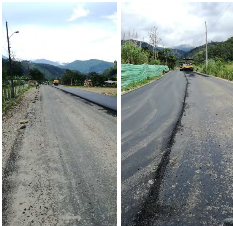
Ilustración 18. Trabajos de asfaltado en la vía San Carlos-Namírez Fuente: Equipo Consultor, 2020.
